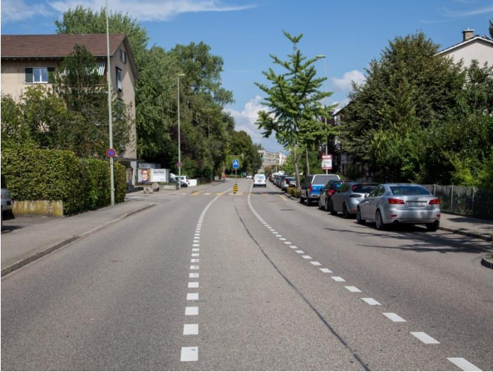
Beispiel Mehrzweckstreifen: Oberwilerstr. Binningen
