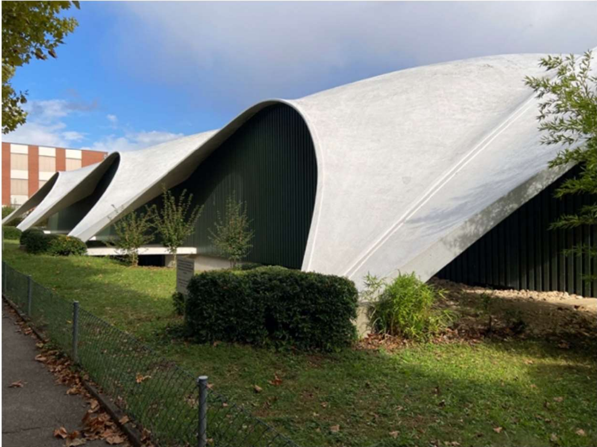
Längsfassade mit Schalenfüssen und Zugbändern
