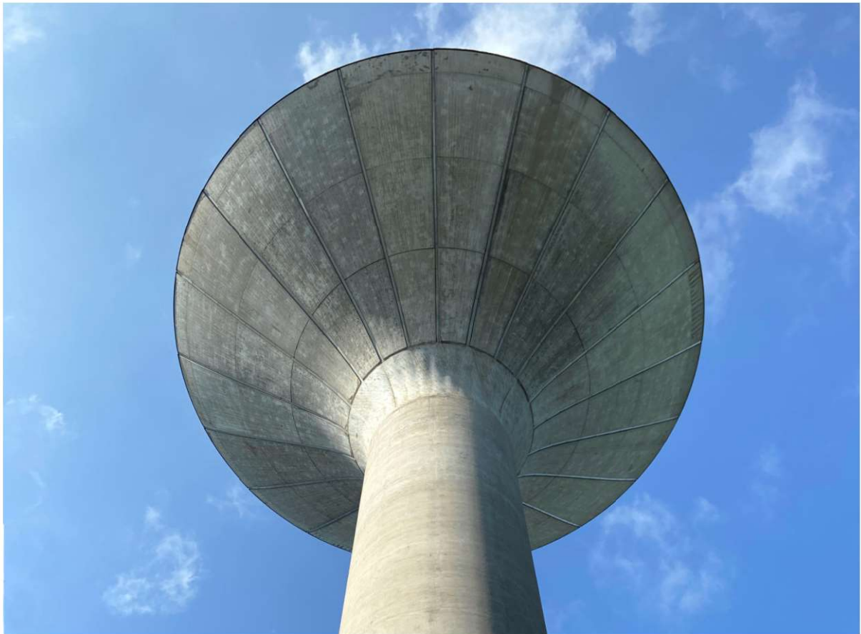
Der Kegel besteht mit grosser Wahrscheinlichkeit aus fein geschalteten Fertigbetonelementen
