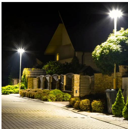
Abbildung Strassenbeleuchtung mit 3'000 K
