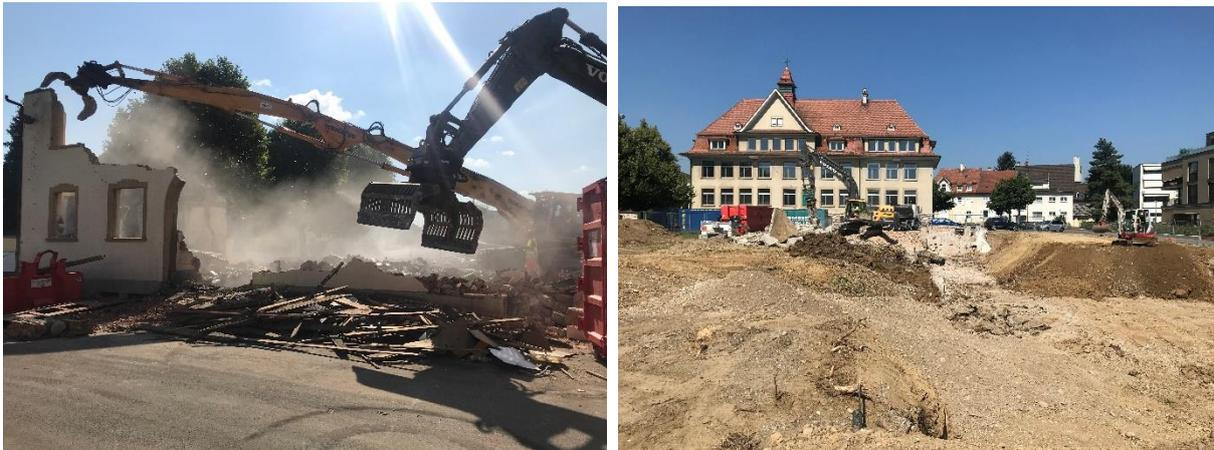
Abbildung 4: Rückbauarbeiten Turn- und Konzerthalle Gartenstrasse
