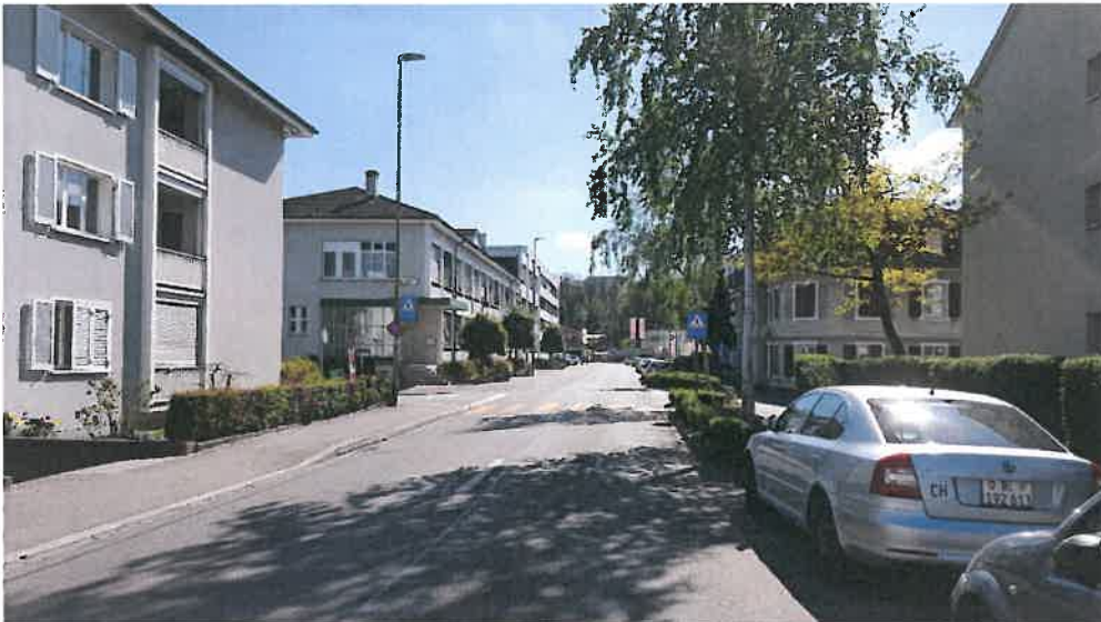
Fussgängerstreifen Fabrikstrasse / Lettenweg, Ansicht in Richtung Kreisel Binningerstrasse nach Entfernung des Baumes auf der linken Strassenseite
