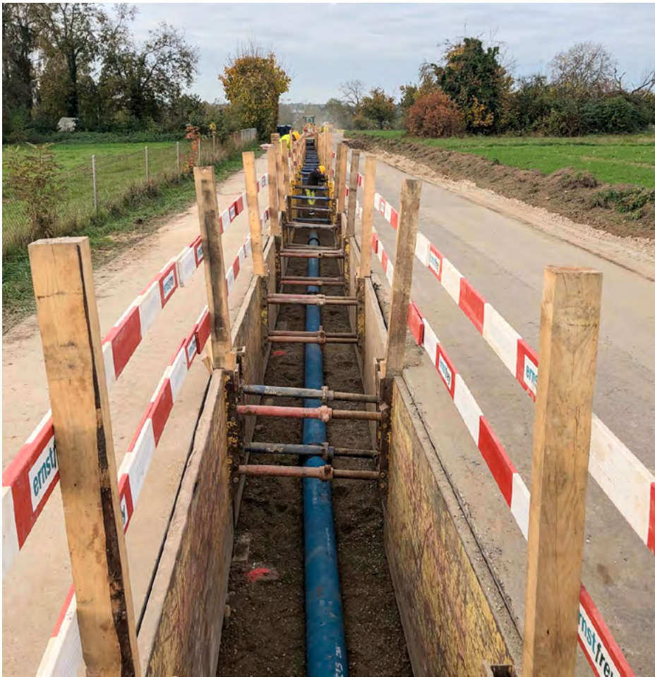
< Oberwilerstrasse: Neue Wasserleitung vom Himmelrichweg bis zum Herrenweg.
