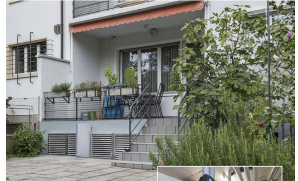
Luftreinlass und -auslass unter der Terrasse, die beiden innen aufgestellten Wärmepumpen im Heizungskeller.
