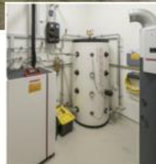
Schwebender Einbau der Außeneinheit beim Kellereingang, Heizungskeller mit Heizungsspeicher und Wärmepumpenboiler.
