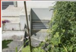
Wärmepumpe im Keller, Ansaugöffnung neben dem Eingang (links), Ausblasen durch Kellerfenster (rechts).
