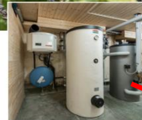
Wärmepumpe im Vorgarten anstelle des Velounterstands; Wärmepumpenboiler; Warmwasser- und Heizungsspeicher im Heizungskeller.
