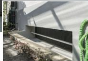
Wärmepumpe im Keller, Ansaugöffnung neben dem Eingang (links), Ausblasen durch Kellerfenster (rechts).
