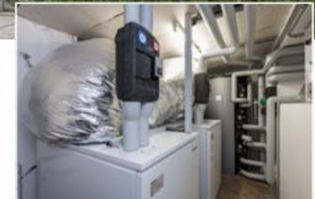
Luftreinlass und -auslass unter der Terrasse, die beiden innen aufgestellten Wärmepumpen im Heizungskeller.
