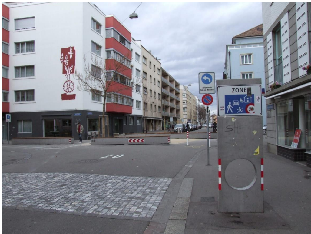
Variante Basel-Stadt mit Betonelement (Allerdings nur in Begegnungszonen umgesetzt)
