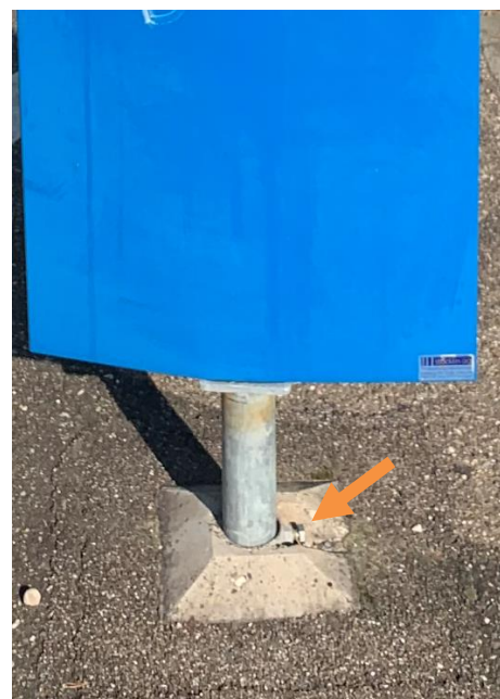
Befestigung mit nur einer Feststellschraube
